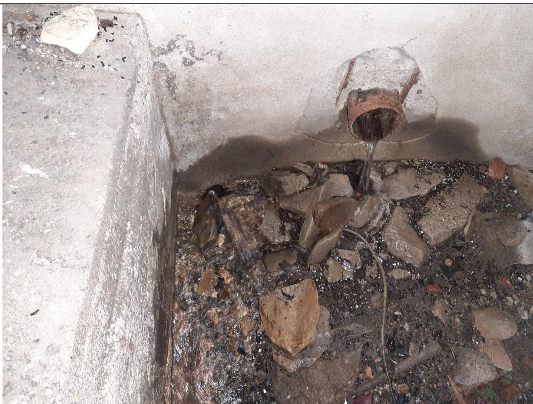
Zaústění balastních vod
