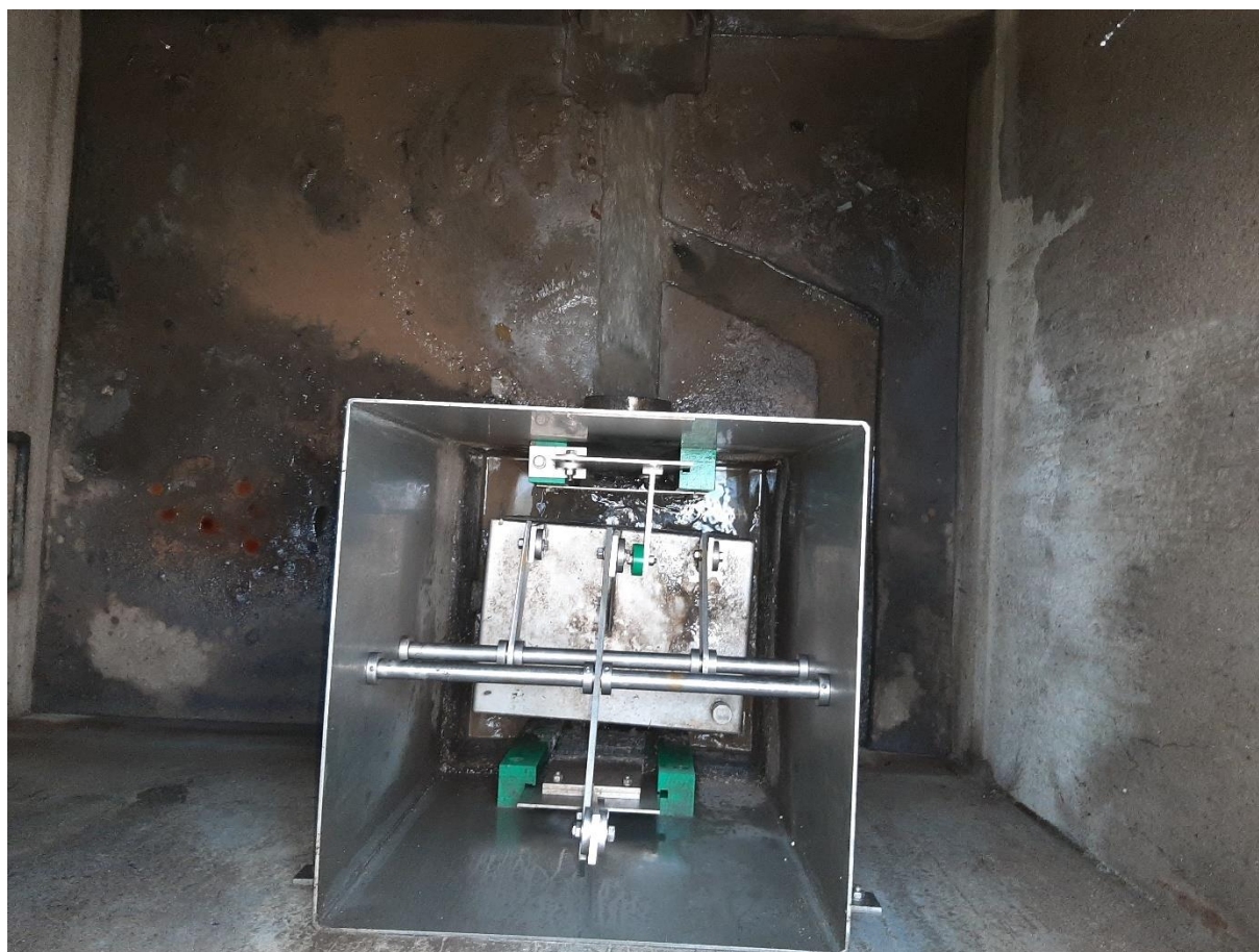
Obr. 6 OK1B – pohled do regulační komory
